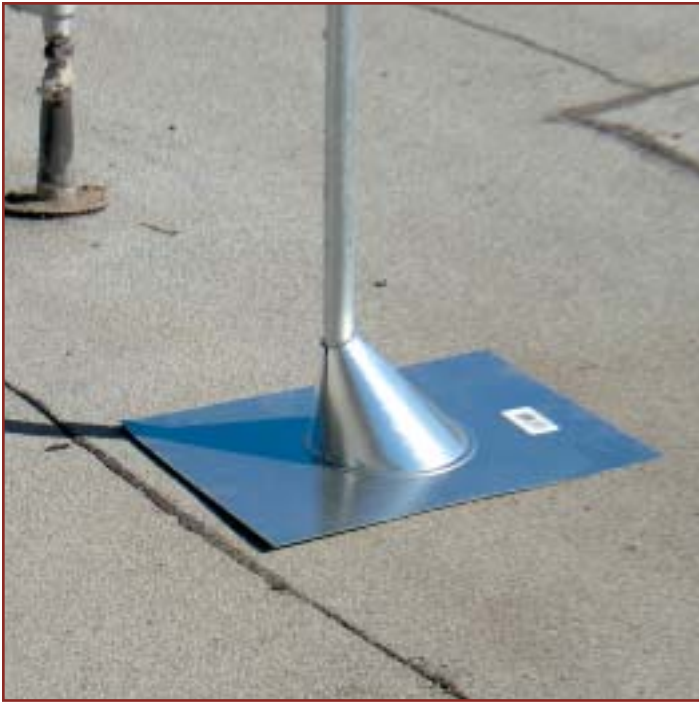
New conduit penetrations.
