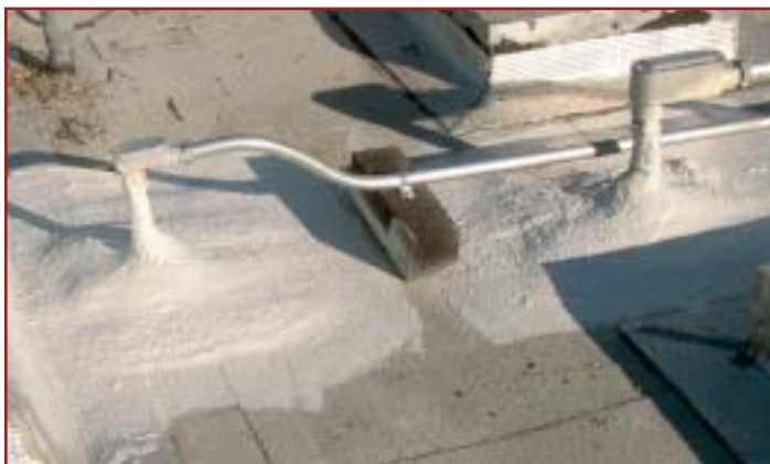
New conduit penetrations.
