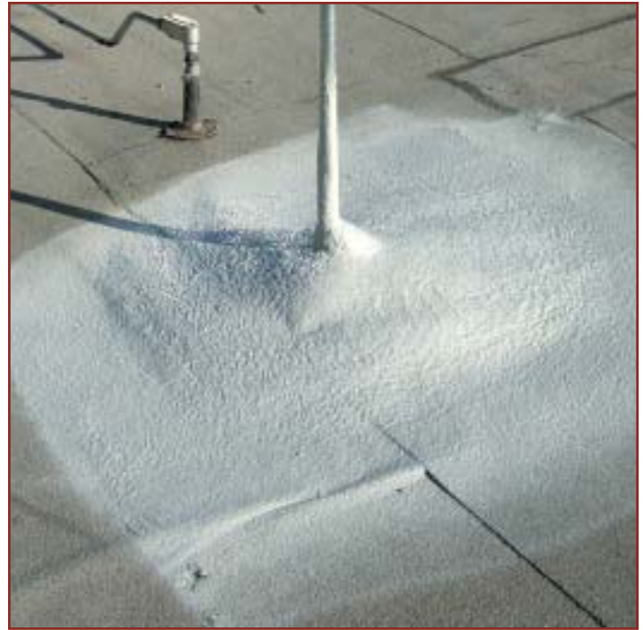
New conduit penetrations.
