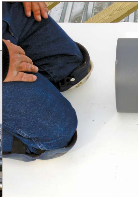
Photo 2 — Aligning membrane selvage edge
