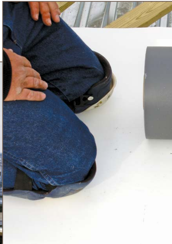
Photo 2 — Aligning membrane selvage edge
