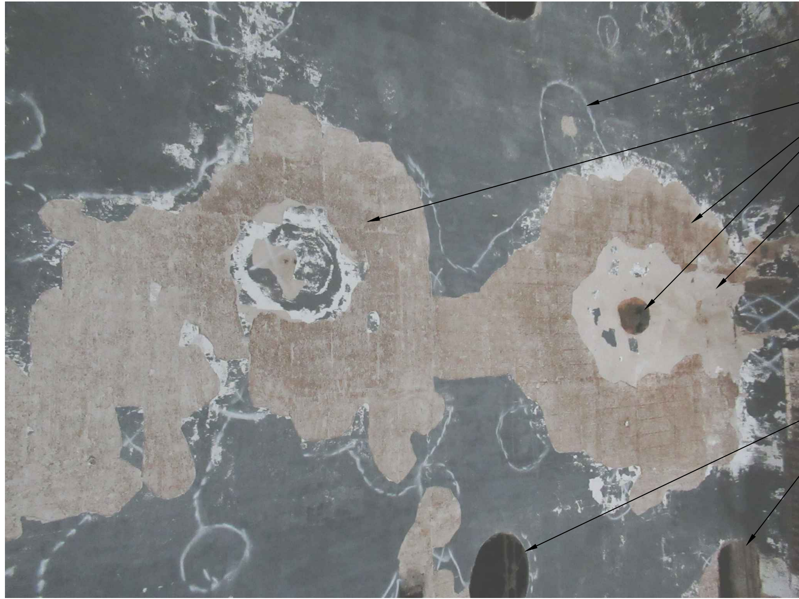
A1 Plaster Delaminations SCALE: 1 1/2" = 1'-0"
